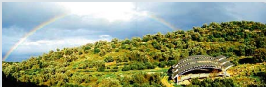
Άποψη της Ελεύθερνας με το υπό κατασκευήν Αρχαιολογικό Μουσείο. / A view of the archaeological museum at Eleutherna, currently under construction.
